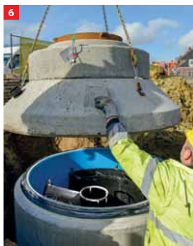
Uždedama viršutinė atskirtuvo dalis
