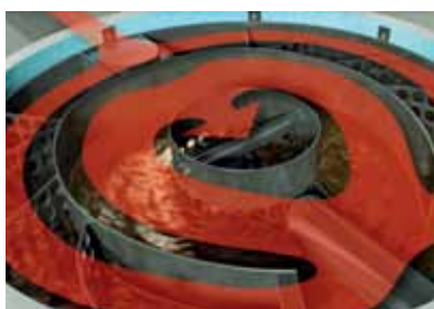
Atskyrimo sekcijoje vienu metu atskiriamos nuosėdos ir lengvieji skysčiai
