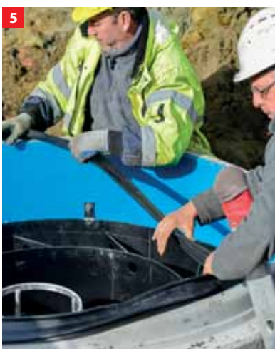
Ištvirtinama žiedinė tarpinė
