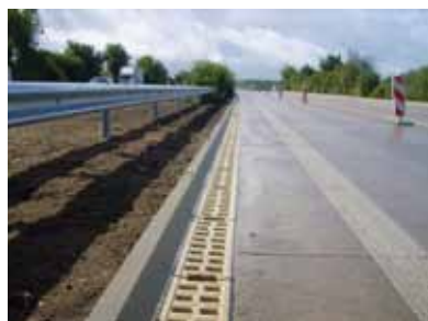
ACO Monoblock RD 200 V išilgai eismo pakloti latakai Vokietijoje greitkelyje A1
