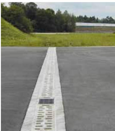
ACO Monoblock RD 300 su ištekėjimo dėže Mančingo miesto oro uoste Vokietijoje
