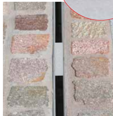
Plyšiniai latakų dangčiai sujungti jungiamuoju elementu
