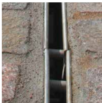
Du šalia vienas kito sumontuoti plyšiniai latakų dangčiai be jungiamojo elemento
