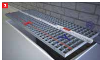
Išmatuokite grotelių plotį X ir atstumą iki sienos Y. Atpjaukite keturis profiliuotus elementus ir sujunkite į rėmą.
