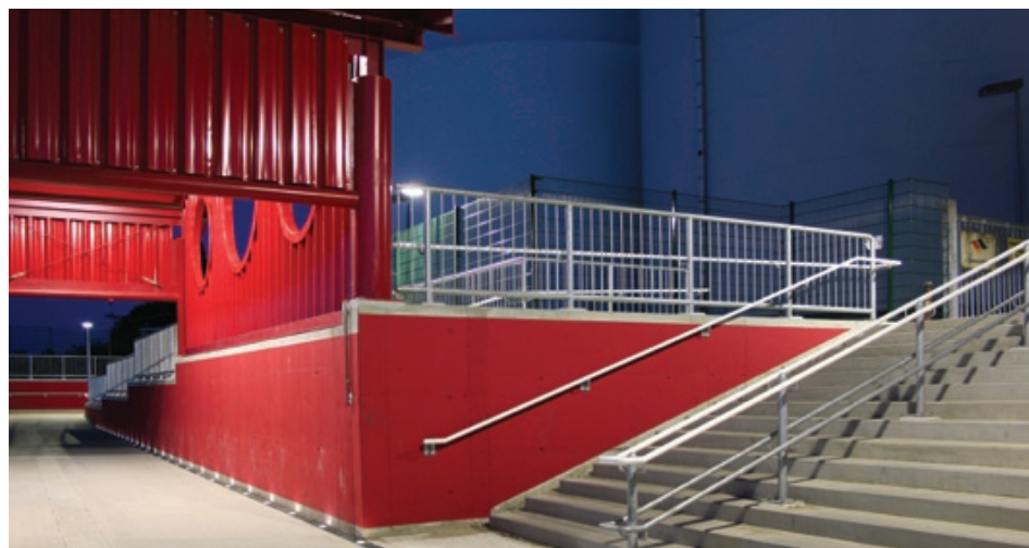
Rekonstruojant Kylio uosto prieplaukos pastatą, buvo sumontuoti Multiline V 100 G latakai su ketinėmis grotelėmis ir ACO Lichtpunkt šviesomis.
